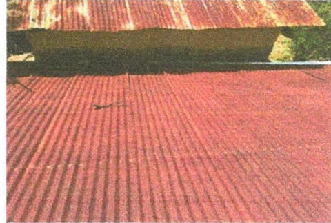
Foto 2: Sustitución de techo.
