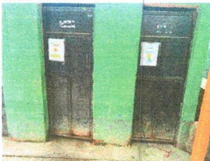
Foto 5: Mantenimiento a puertas de metal
